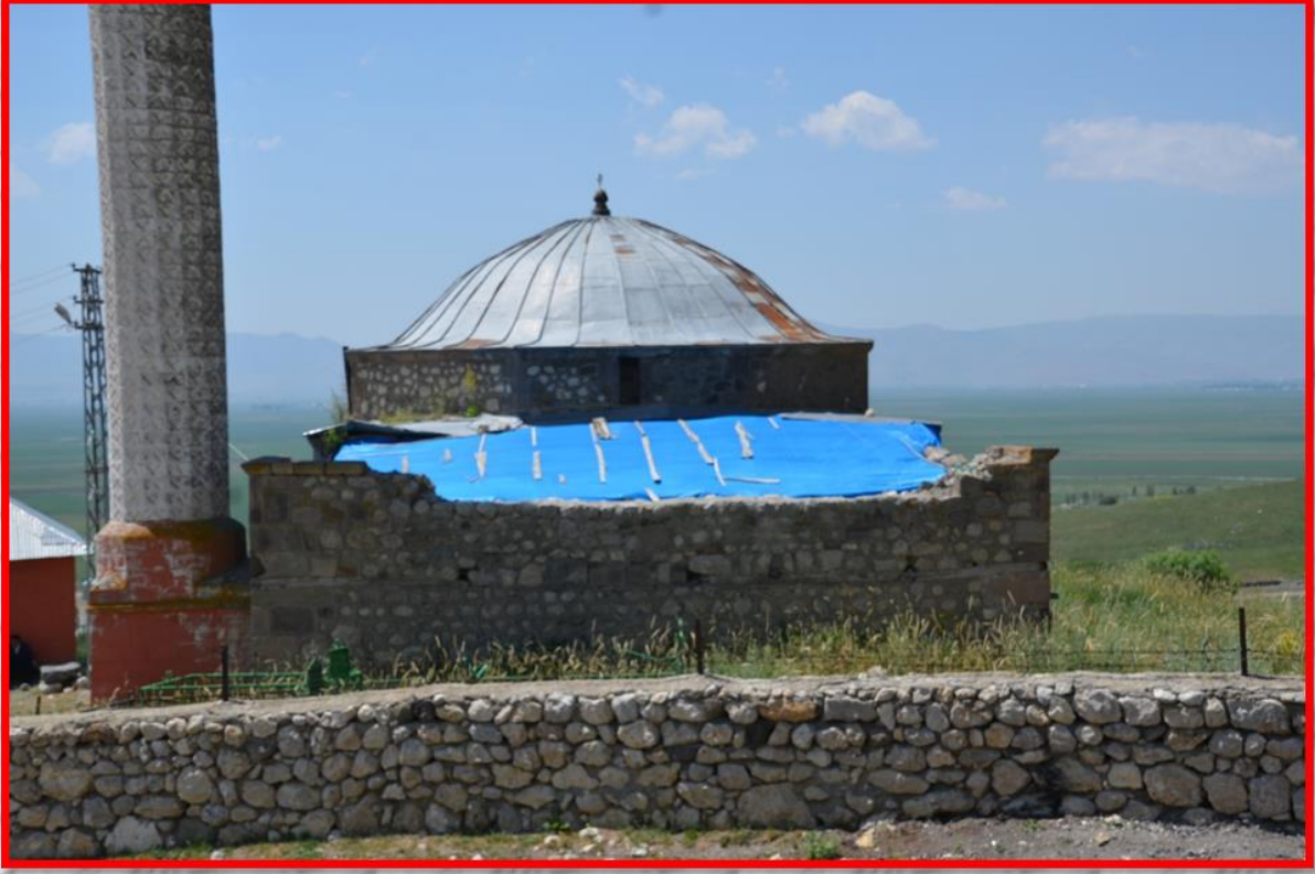
Toprakkale Camii (Eski Hali)
